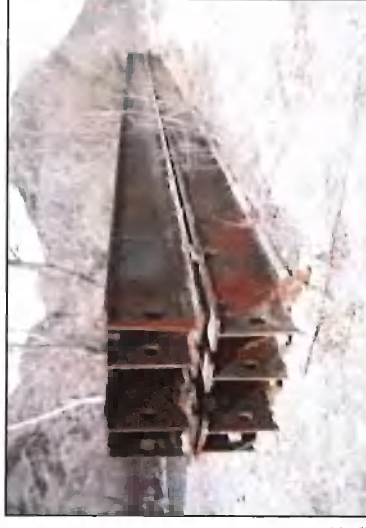
Les poutres IPN acier qui vont constituer la passerelle provisoire
